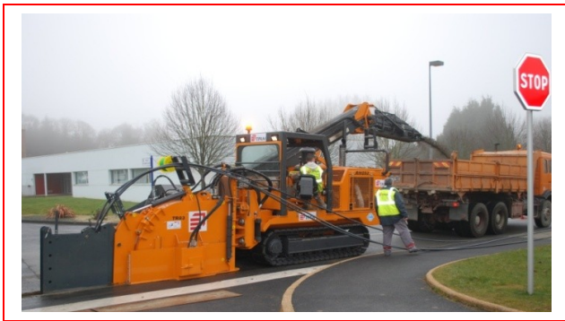
Trancheuse pour pose de cables
